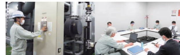
ガスコージェネレーションシステム TMES(株)様との打ち合わせ風景
